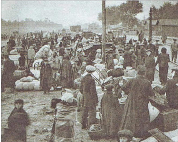
Бежанцы на чыгуначнай станцыі
